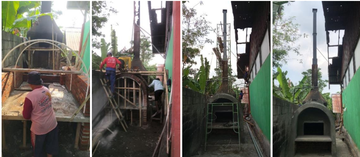
Gambar 4. Proses pembuatan alat pembakar sampah
