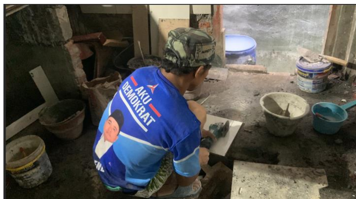
Gambar 6. Pekerja Tidak Memakai APD Saat Menggerinda
